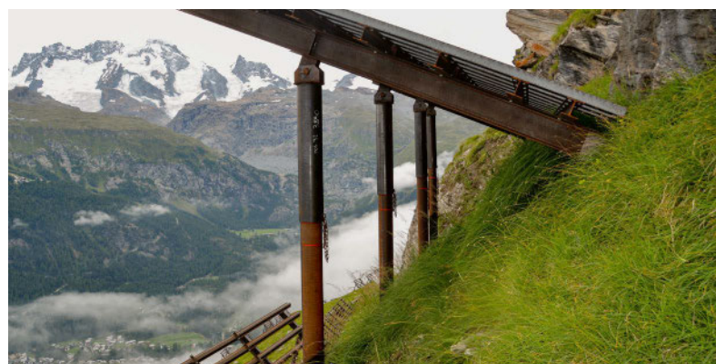
Aufgebaute Testbauwerke. Bild: Berner Fachhochschule BFH
